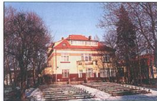
Dawna willa dyrektora jaworznickich kopalń. Widok od strony amfiteatru. Stan obecny
