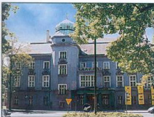
Siedziba kolejnych władz zarządzających górnictwem w Jaworznie. Stan obecny
