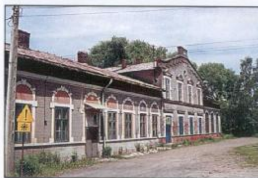
Dom gościnny, kasyno urzędnicze i kino Cementowni Szczakowa SA na Poczekanej. Stan obecny
