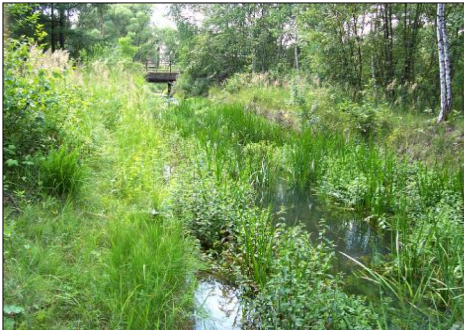
Kanał odwadniający Prochownia (2004 r.)
