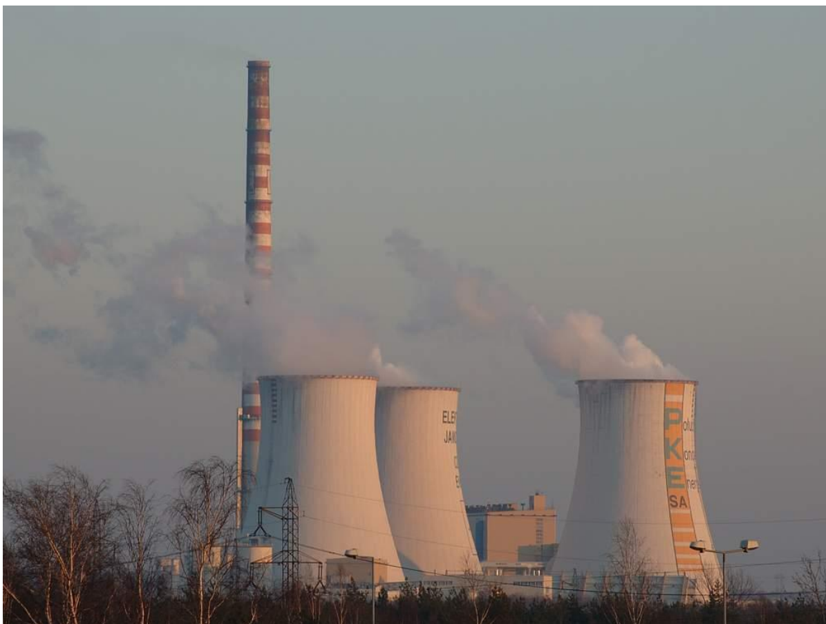
Rys. 2.8 Elektrownia w Jaworznie
