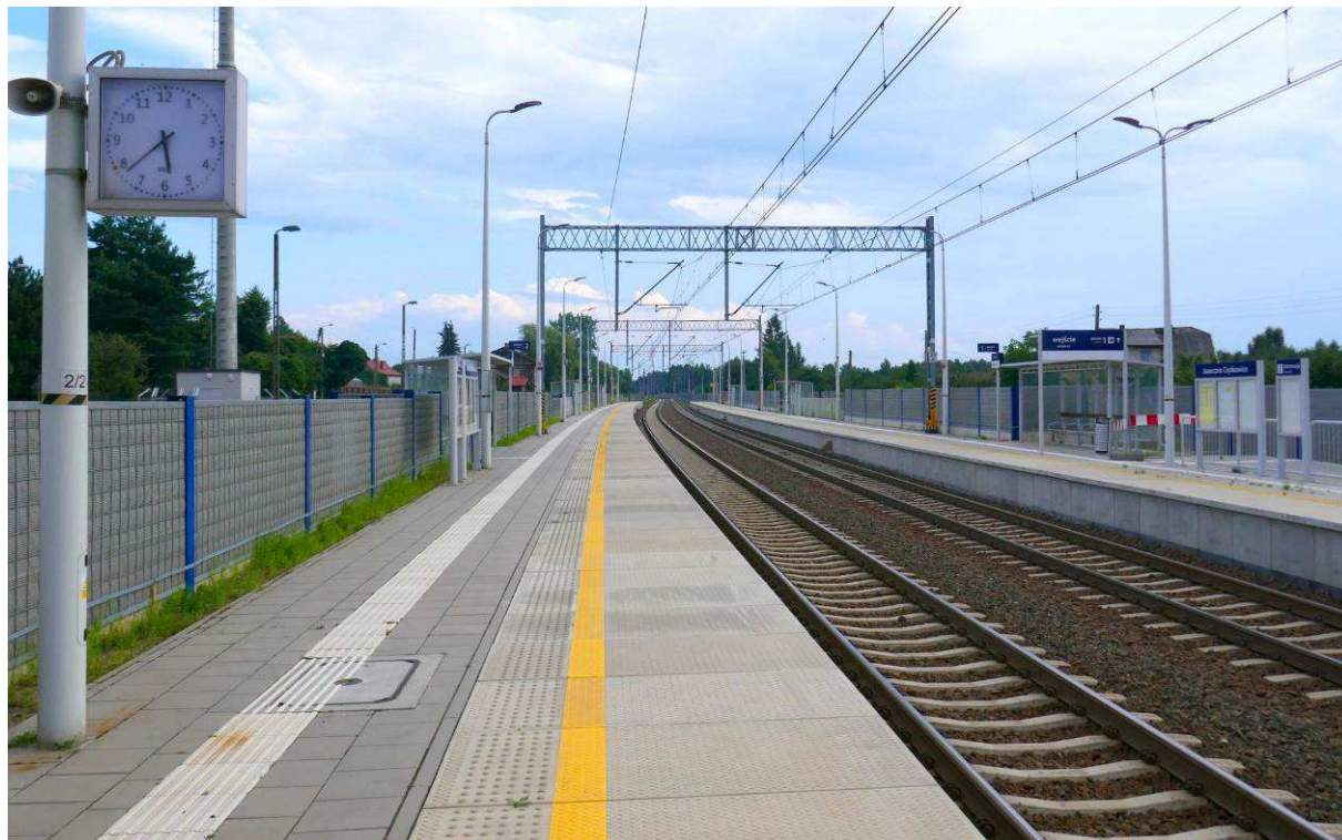
Fot. 2 Przystanek kolejowy Jaworzno Ciężkowice
