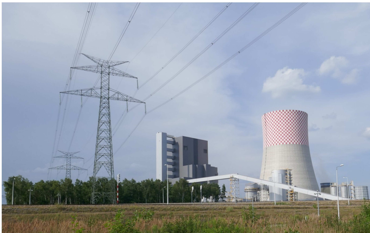
Fot. 1 TAURON Wytwarzanie S.A. – Oddział Elektrownia III w Jaworznie – blok 910 MW
