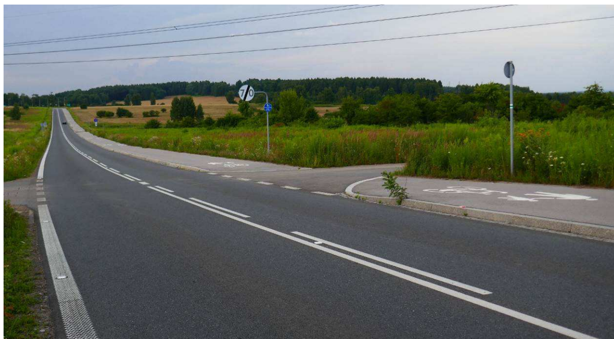
Fot. 6 Obwodnica Północna
